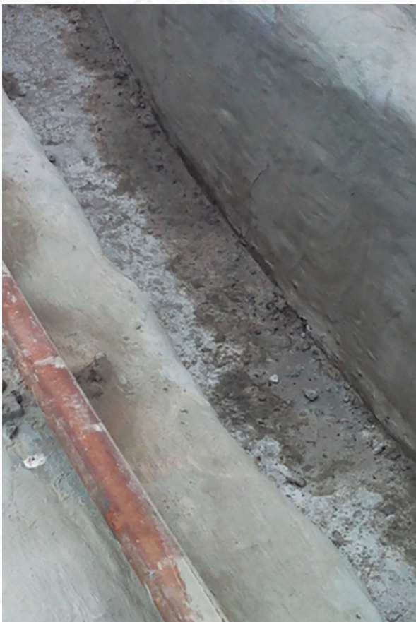
Рисунок 5. Вид конструкции после восстановления защитного слоя
