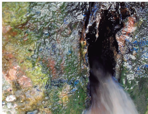
Рисунок 3. Напорная течь
