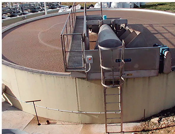
Рисунок 2. Радиальный флотатор мясокомбината
