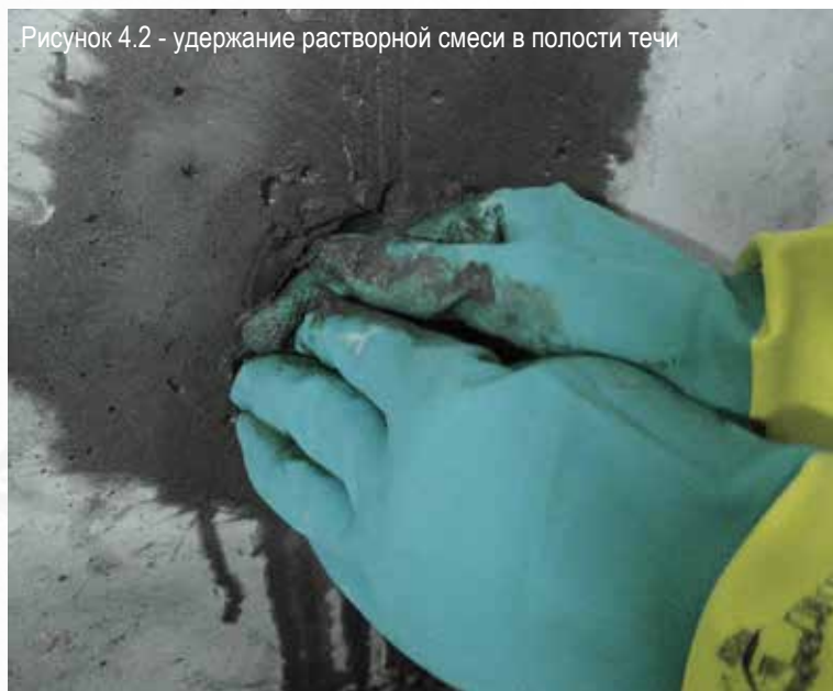
Рисунок 4.1 - Остановка течи
