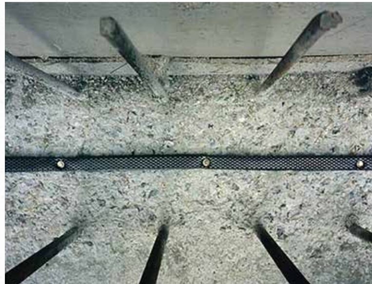
Рисунок 7 – Монтаж гидроизоляционного жгута «Пенебар» (вид сверху)
