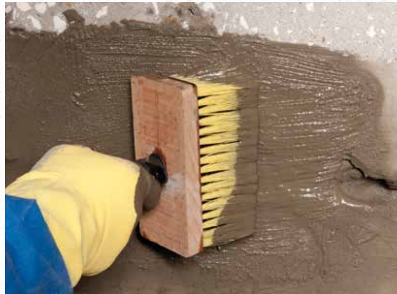
Рисунок 11 – Обработка штрабы растворной смесью «Пенетрон»
