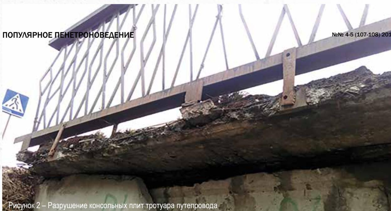
Рисунок 2 – Разрушение консольных плит тротуара путепровода
