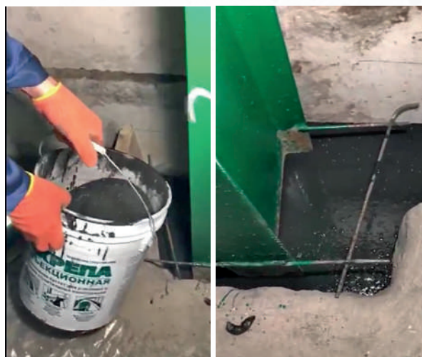
Рис. 6. Заливка растворной смеси «Скрепа М600 Инъекционная»
