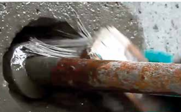
Рис. 9. Увлажнение и обработка поверхности бетона раствором смеси «Пенетрон»
