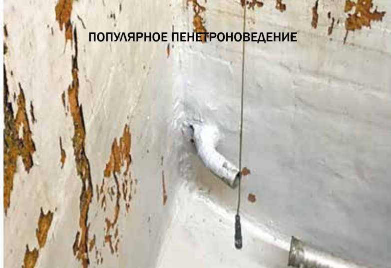
Рис. 4. Место ввода трубопровода
