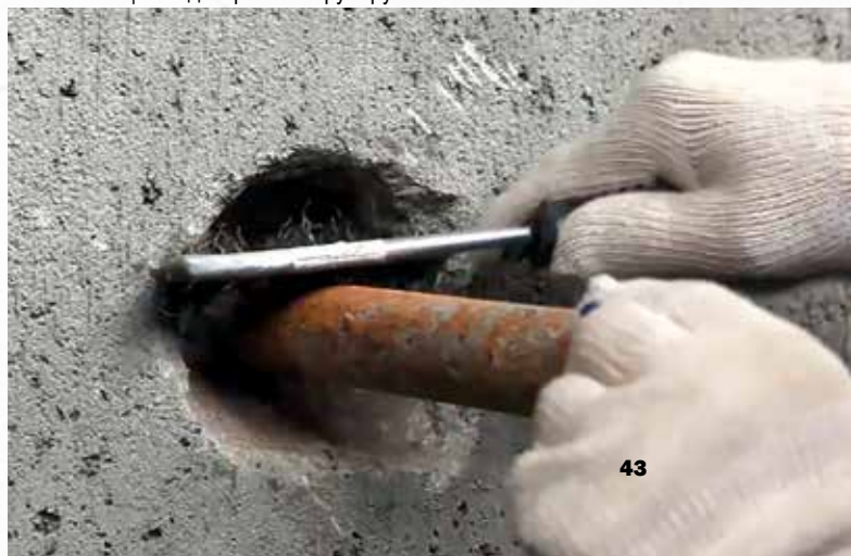
Рис. 6. Общий вид штрабы вокруг трубы
