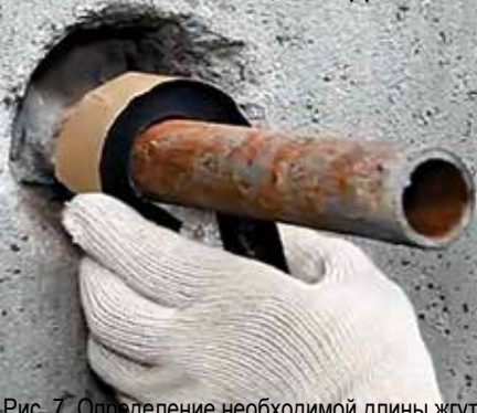
Рис. 7. Определение необходимой длины жгута «Пенебар»
