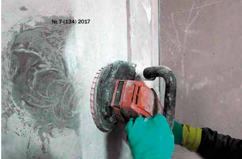
Рис. 3. Очистка поверхности
