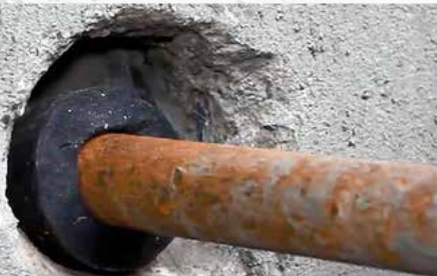
Рис. 8. Гидроизоляционный жгут «Пенебар» вокруг трубопровода
