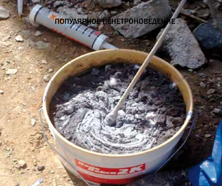
Рис. 16. Приготовление «ПенеПокси 2К»
